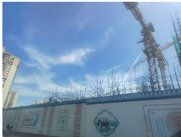
图 2-2 现状围挡及施工现场
